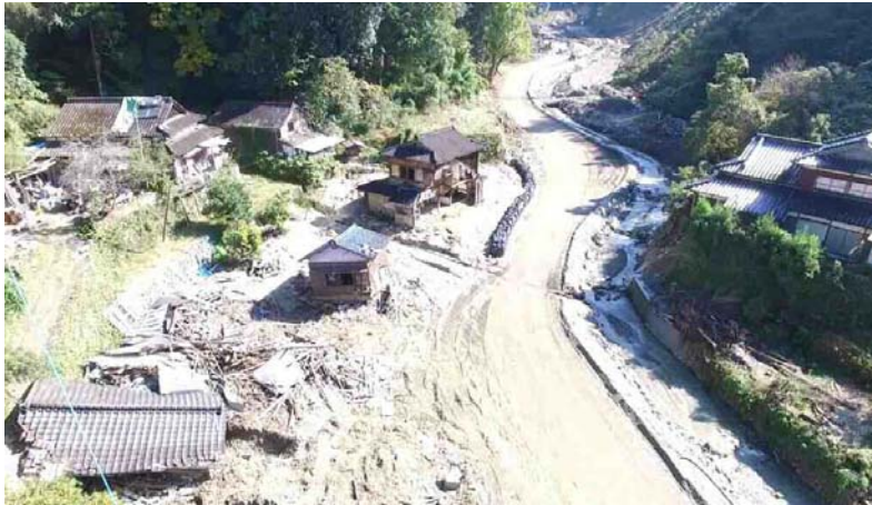
▲ 赤谷川水系小河内川被災状況
