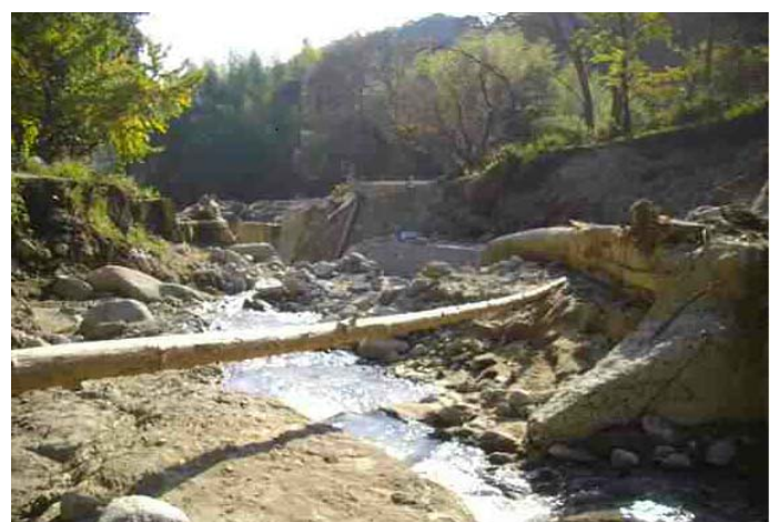
▲ 白木谷川 白木2号線被災状況
