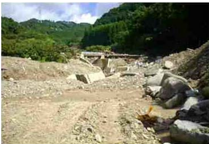
▲ 北川水系導目木川被災状況
